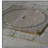
6. Belagssanierung bei Schacht- abdeckungen Seite 14 – 15
