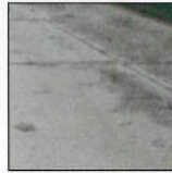
3. Kleinflächige Flickarbeiten mit Bitumenemulsion Seite 8 – 9
