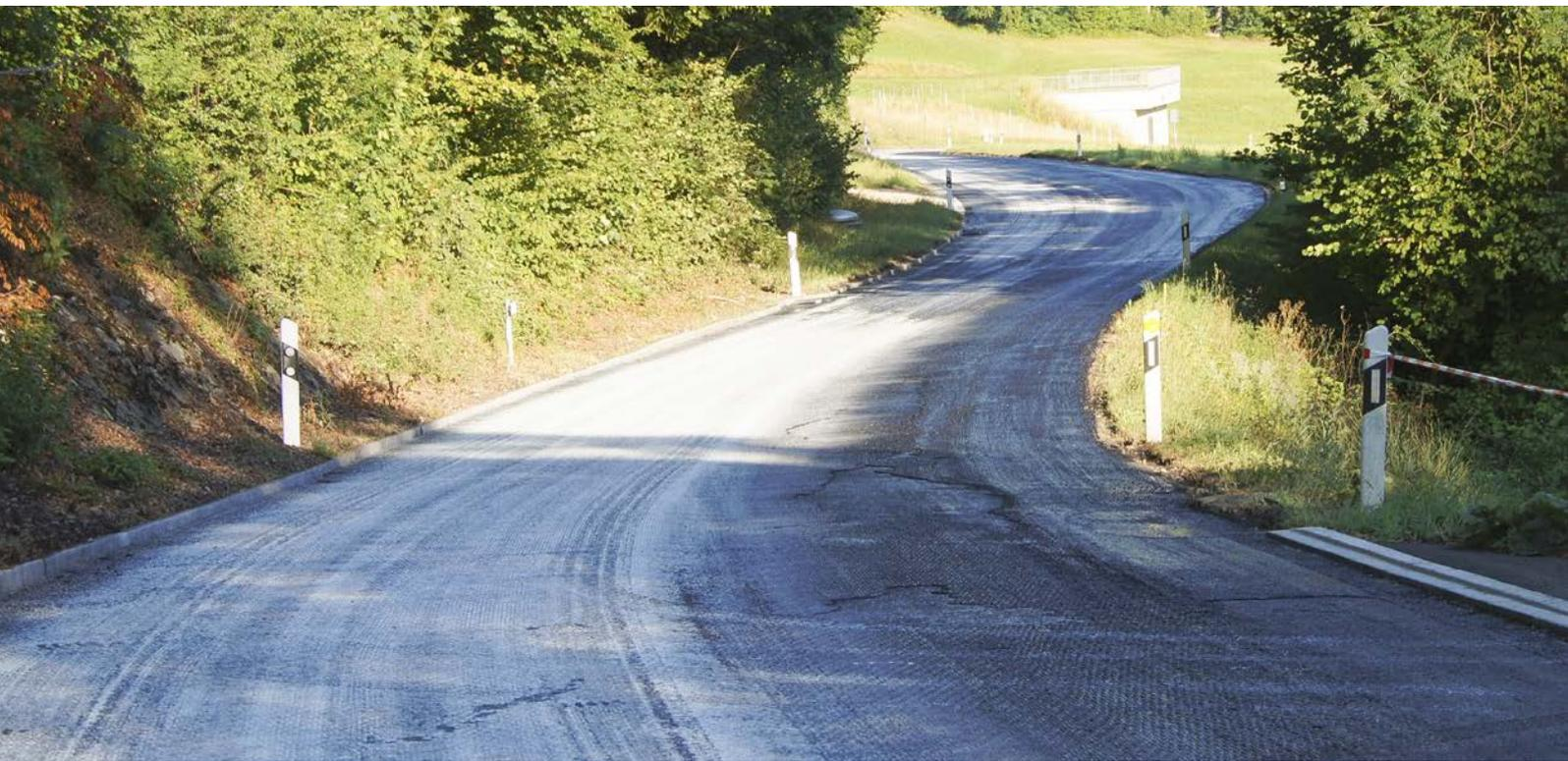
**Die im Schichtenverbund applizierten Haftkleber neigen bei hohen Aussentemperaturen dazu, die LKW-Reifen zu verkleben, und verschmutzen die Zufahrtsstrassen und neu erstellte Bauteile wie Kreisel etc. Um diese Ärgernisse zu verhindern, hat die Firma CTW nun die Lösung.**
