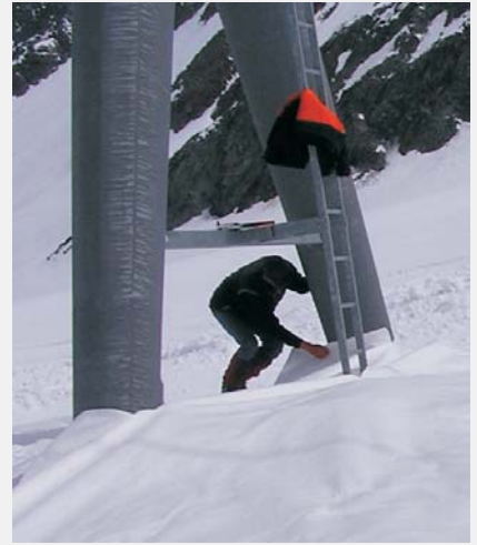
GLS kann zugeschnitten werden und passt sich so Pylonen oder Felsen an.
