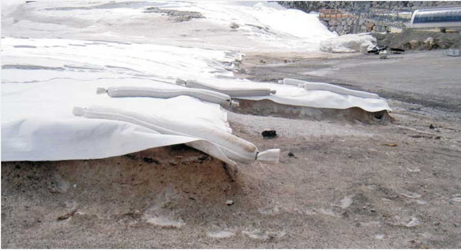
Nach nur 3-4 Monaten zeigt sich eine wesentlich geringere Abschmelzung unterhalb der Gletscherschutzmatte im Vergleich zur Umgebung.
