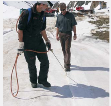
GLS-Matten können einfach mit einem speziellen Gasbrenner zugfest miteinander verbunden werden.
