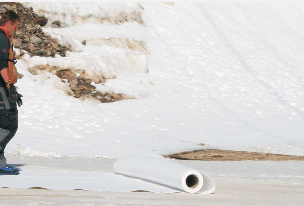
GLS-Matten können einfach mit einem speziellen Gasbrenner zugfest miteinander verbunden werden.
